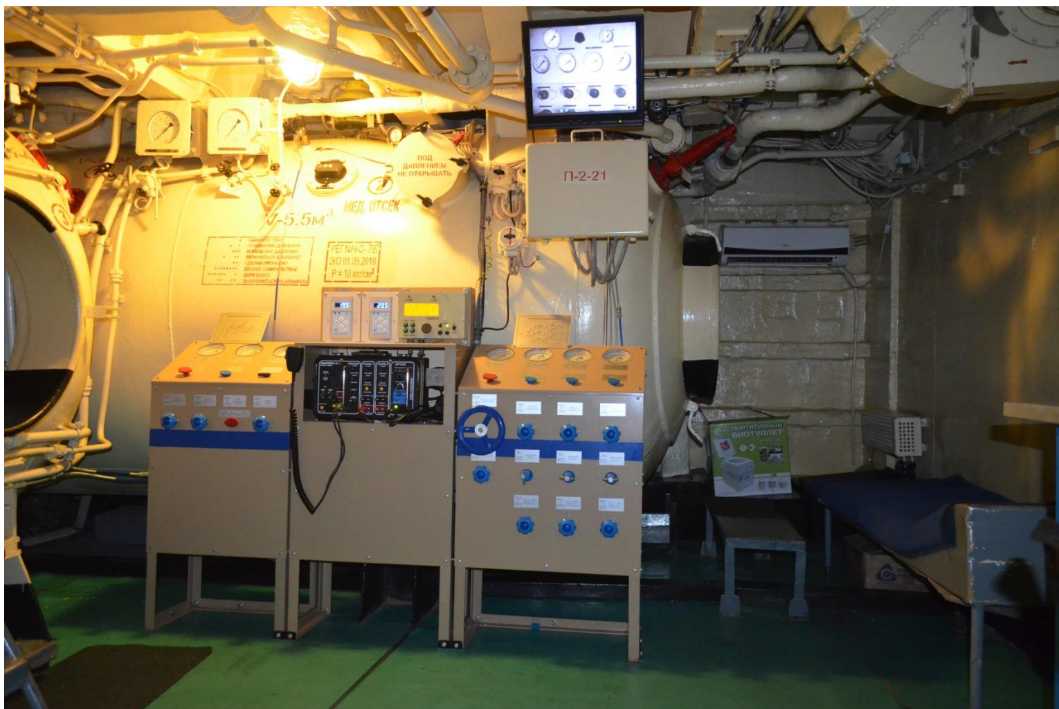
Пульт управления стационарной дыхательной системой отсеков №2; №3 и №4 барокамер левого борта и пульт управления дозированной подачи кислорода в отсек №2 (медицинский)
