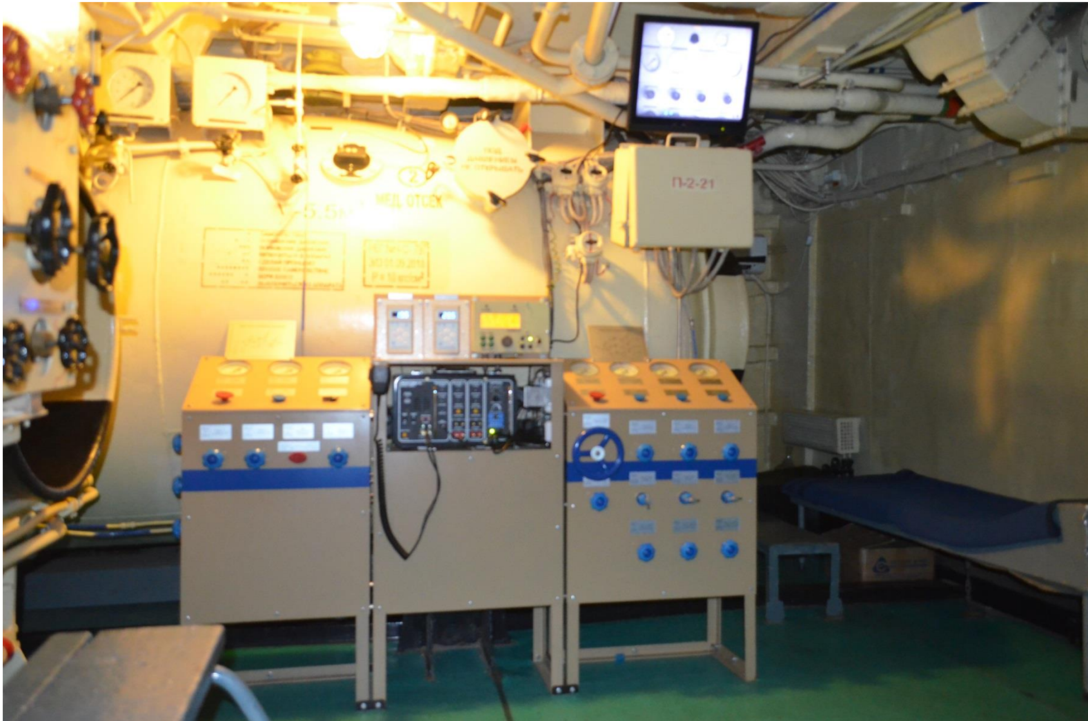
Полка газоанализа (в центре) отсеков барокамер левого борта судна
