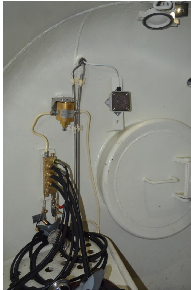
Динамик-микрофон (над люком), установленный в отсеке №2(медицинском)
