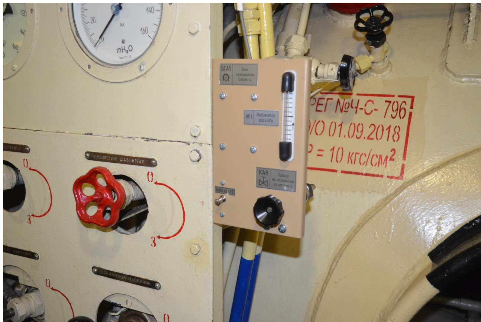
Блок датчика газоанализатора ПГК-06-25Р1, осуществляющий измерения концентрации кислорода в отсеке барокамеры
