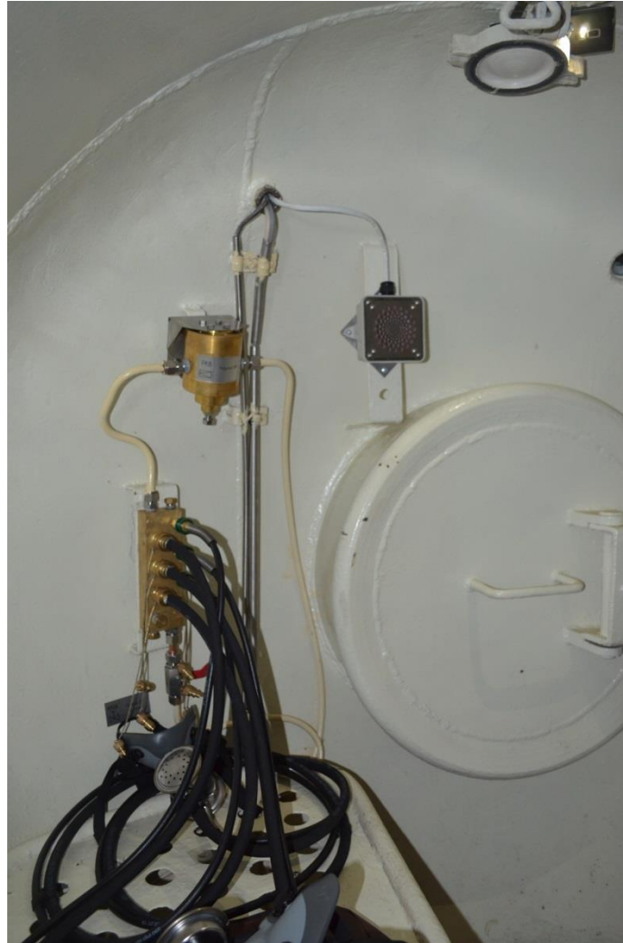
Отсек барокамеры. Коллектор стационарной дыхательной системы с присоединенными к нему масками BIBS (три маски) и регулятор расхода выдоха из масок
