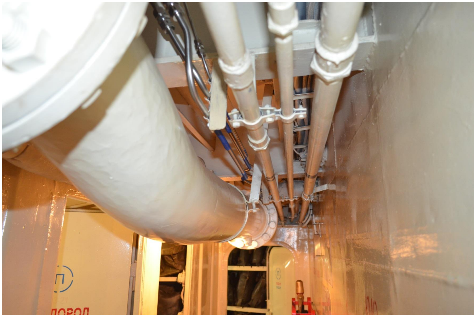
Прокладка трубопроводов кислорода высокого давления в коридоре судна
