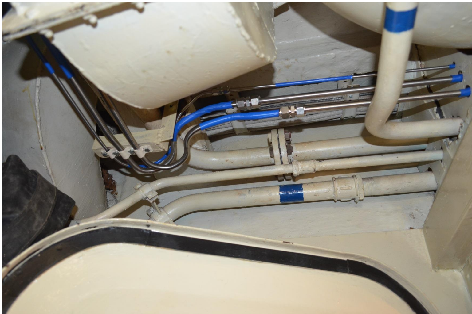
Прокладка трубопроводов кислорода высокого давления в помещении декомпрессионного оборудования
