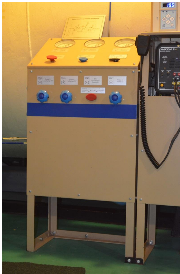
Пульт управления дозированной подачи кислорода в отсек №2 (медицинский) барокамер левого борта
