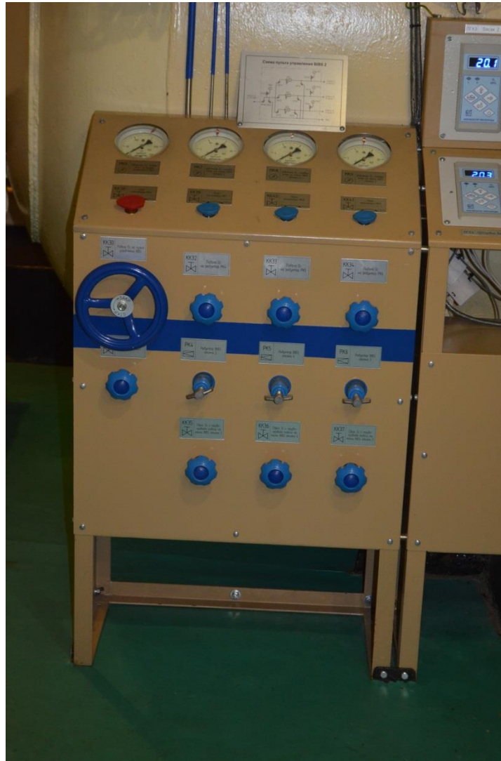
Пульт управления стационарной дыхательной системой отсеков №2; №3 и №4 барокамер правого борта
