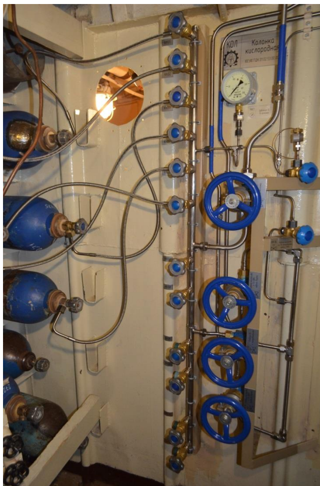
Кислородная колонка и блок газораспределения в помещении гелиокислородных баллонов
